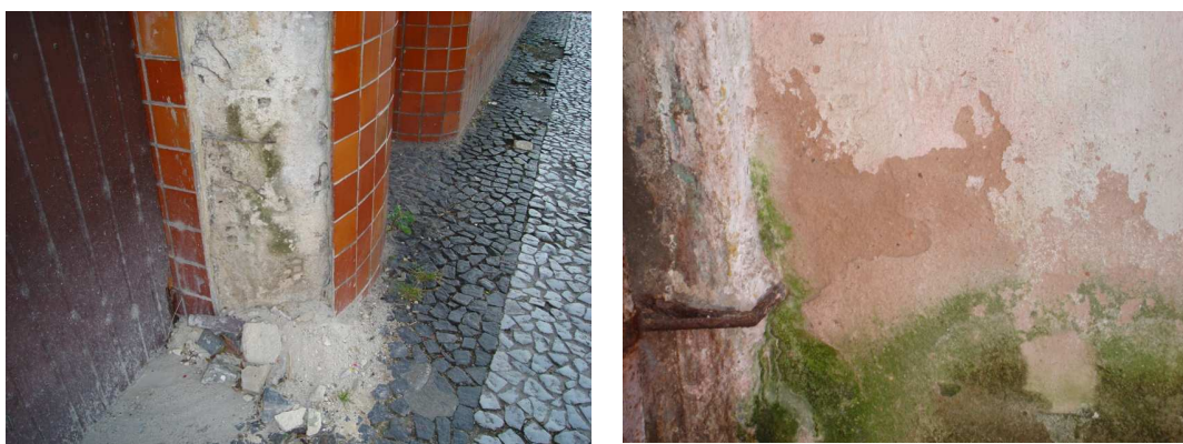
Figura 2. Desagregação da argamassa com Saibro
