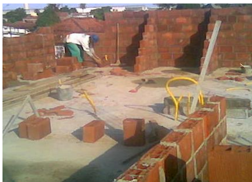
FIGURA 2 – Detalhe dos blocos utilizados na alvenaria e do processo de pulverização em campo.
