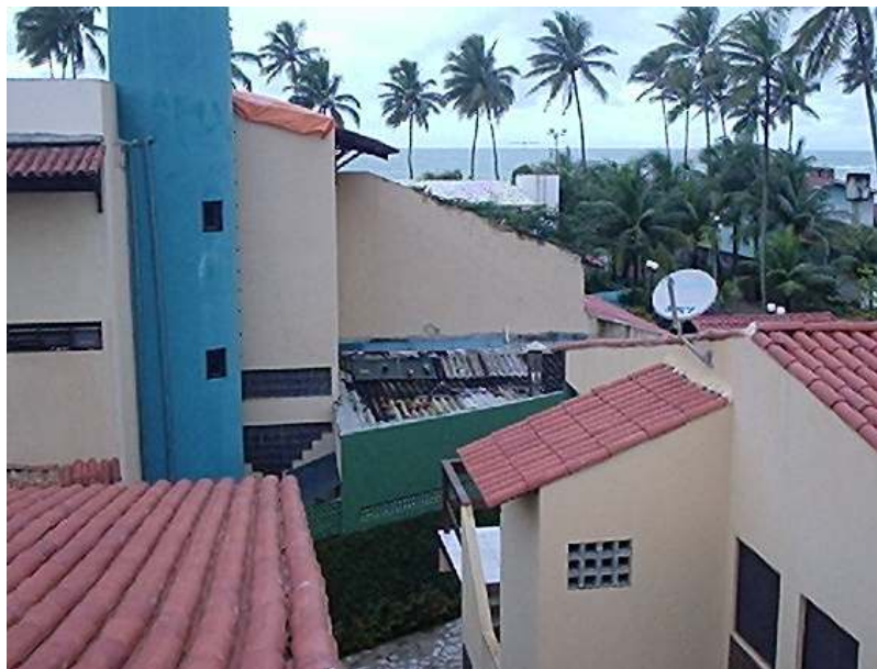
Figura 6 – Vista da laje onde maturaram os CP's das amostras 2e 3
