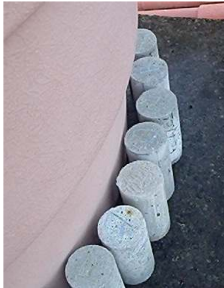
Figura 5 – CP's das amostras 2 e 3 localizados sobre laje do reservatório superior do residencial
